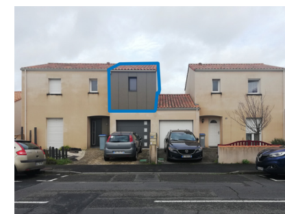
Surélévation, 83 rue de la Profondine
