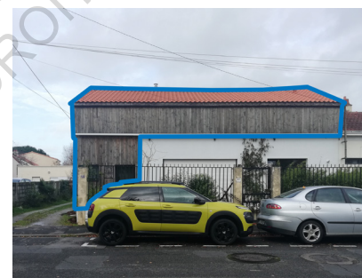
Surélévation, 21 rue des Saules
