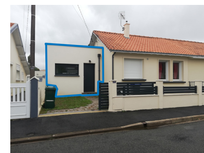
Extension, 17 rue des Robardières
