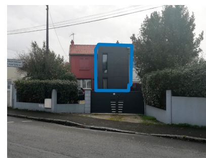
Extension, 80 rue de la Jaunaie
