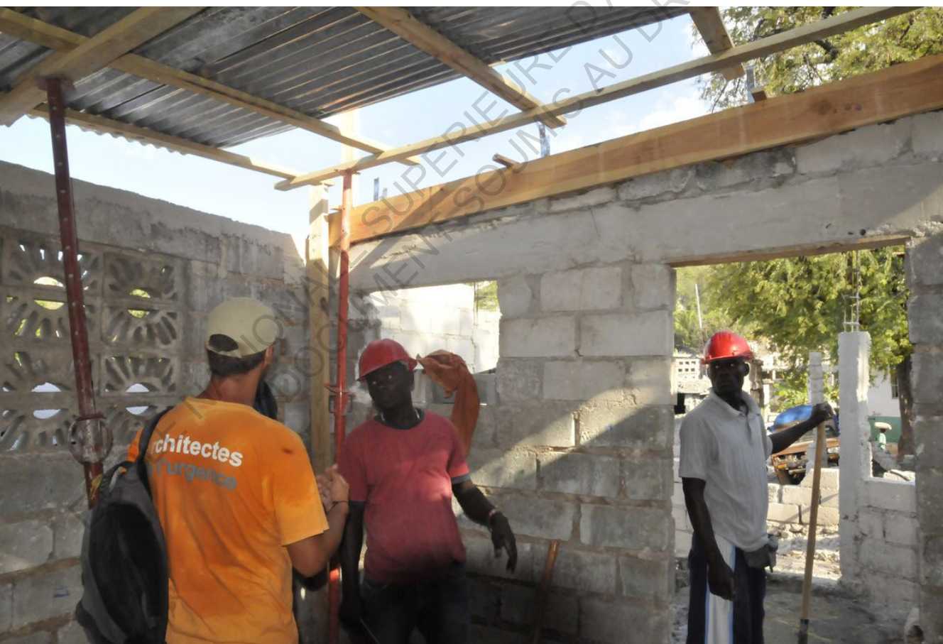
FORMATION DE LA POPULATION LOCALE À LA CONSTRUCTION DE MAISONS ARCHITECTES DE L'URGENCE
