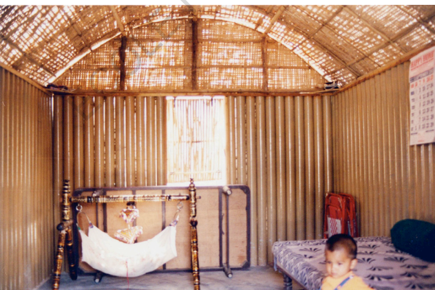
APPROPRIATION ET CHANGEMENT DU TOIT DE LA PAPER LOG HOUSE POUR SUPPORTER LA CHALEUR AFP
