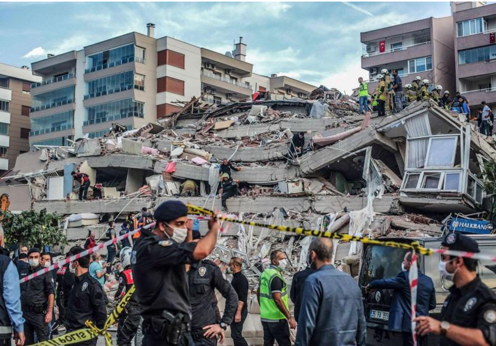
UN IMMEUBLE EST TROP INSTABLE ET DOIT ÊTRE DÉTRUIT EN TURQUIE APRÈS UN SÉISME EN 2020 AFP/MERT CAKIR
