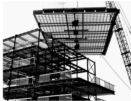
Fig. 15 : photographie du chantier de la Grand'Mare
