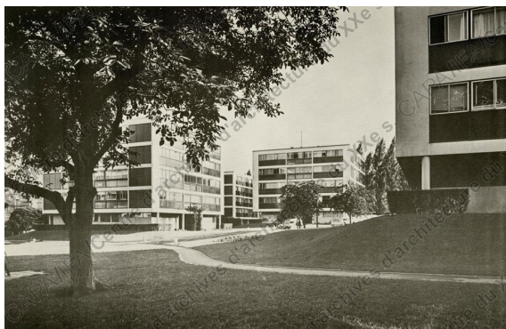
Fig. 9 : photographie de l'ensemble d'habitation "Les Buffets"
