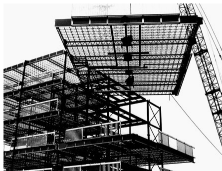
Fig. 15 : photographie du chantier de la Grand'Mare
