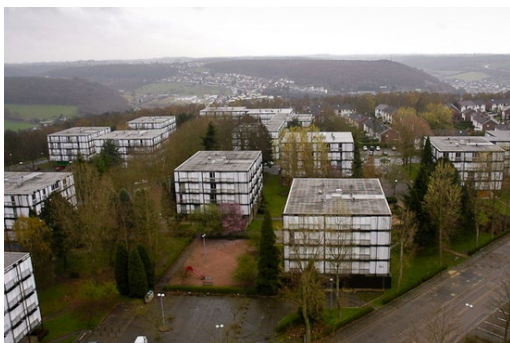
Fig. 14 : photographie vue d'ensemble des plots de la Grand'Mare
