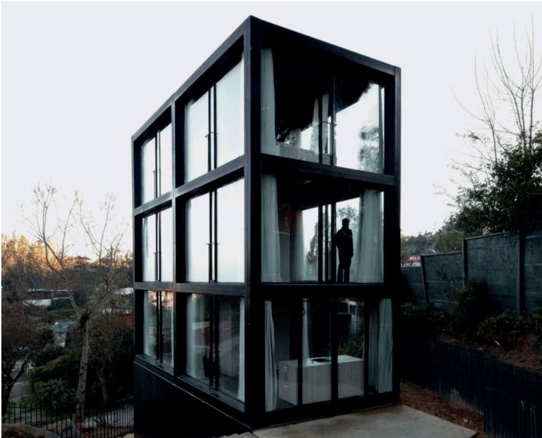
fig.64 : Casa Arco, Pezo von Ellrichshausen, Concepción, 2011
