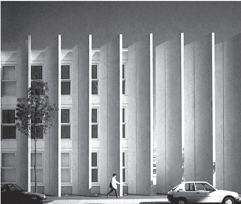
fig.33 : École d'architecture, Nancy, les lames de béton en façade, 1996
