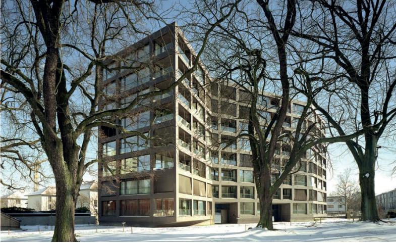
fig.63 : Logements à Schwarzpark, Miller & Maranta, 2004
