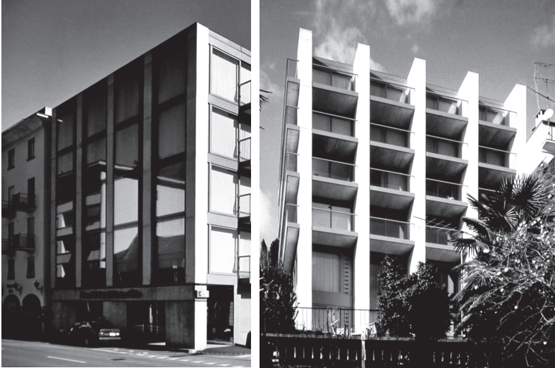
fig.38 : Banque d'état, Brissago, 1997-1999
