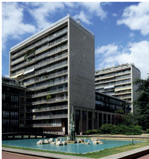
fig.78 : Le Point-du-Jour, Fernand Pouillon, Boulogne Billancourt, 1958-1963
