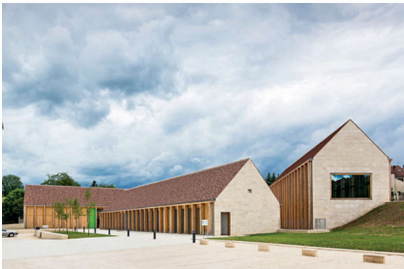
fig.76 : Maison de santé, Vezelay, 2014
