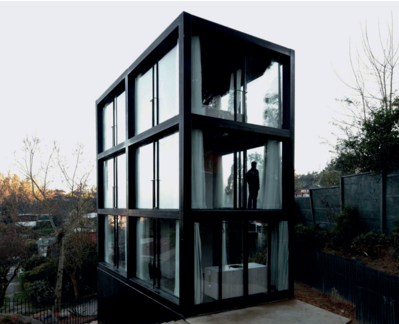
fig.64 : Casa Arco, Pezo von Ellrichshausen, Concepción, 2011
