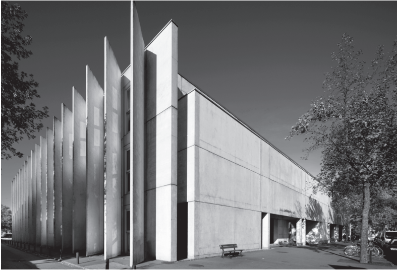
La rencontre des deux systèmes de façade épaisse en béton : les lames et les murs repliés.
