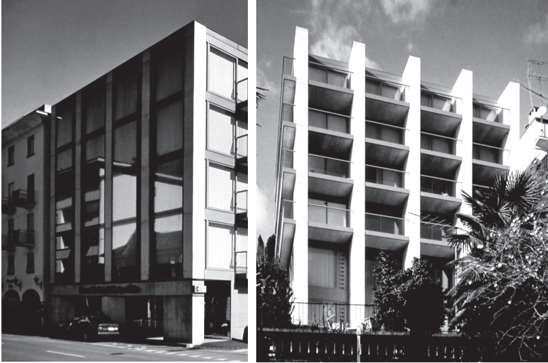
fig.38 : Banque d'état, Brissago, 1997-1999
