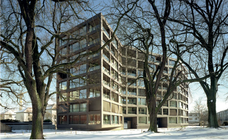
fig.63 : Logements à Schwarzpark, Miller & Maranta, 2004
