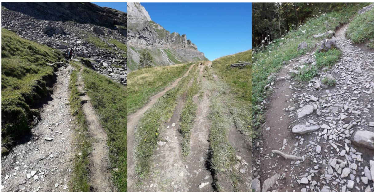
Figure 13 Exemple d'anomalies de sentier rencontrées sur le GR 5. De gauche vers la droite : terrassage, tressage et élargissement
