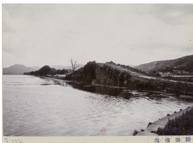
Figure 11 : Photo ancienne du Lac de l'Ouest 1 Shen Qiya En raison de la négligence de la gestion du lac de l'Ouest, la digue Su était en danger de disparaître
