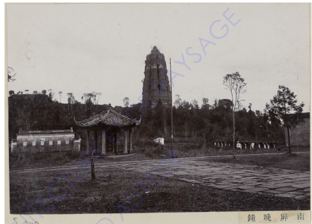
Figure 16 : La tour Leifeng en ruine Shen Qiya Après l'effondrement de la pagode Leifeng en 1924 en raison d'une négligence dans l'entretien, elle est restée en ruine pendant près de 80 ans
