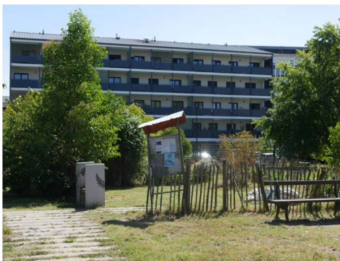
Entrée de l'espace potager
