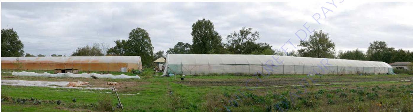
Vue panoramique des serres dédiées au maraîchage
