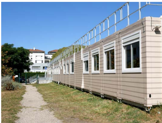
Vue sur l'école depuis l'une des entrées du jardin
