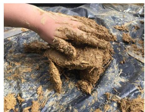
Fig. 105 : fabrication d'une maison en bauge. (@M. MAHDIEH, 2019)
