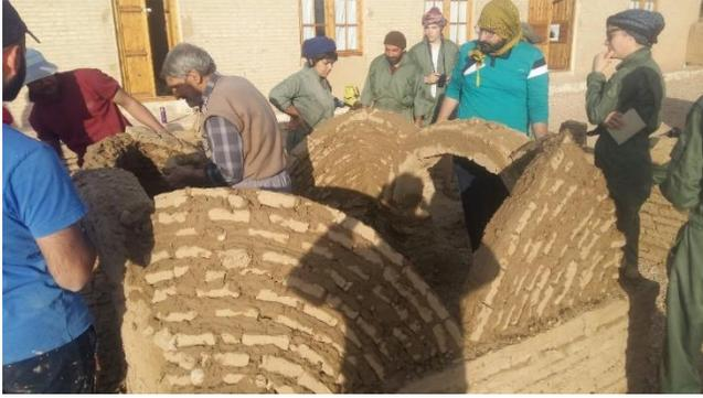
Fig. 63 : construction la coupole en adobe.
