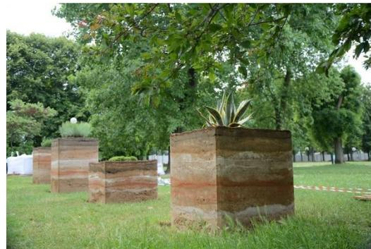
*Fig. 142 : construction en pisé. (© M. MAHDIEH & ©S. BEYGI, 2017)*
