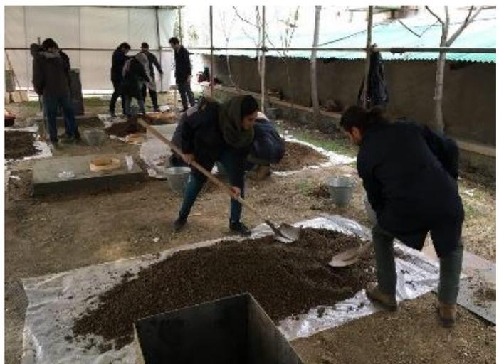
Fig. 38: réalisation d'un pisé. (©M. KHOSRAVI, 2018)
