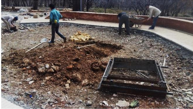
Fig. 43 : préparation du chantier pisé. (©M. MAHDIEH, 2018)
