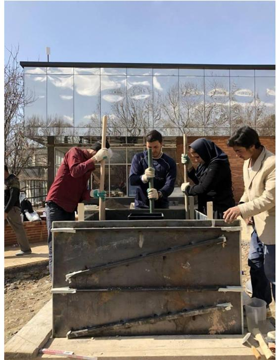
Fig. 44 : réalisation d'un pisé. (©S. BAYAT, 2018)
