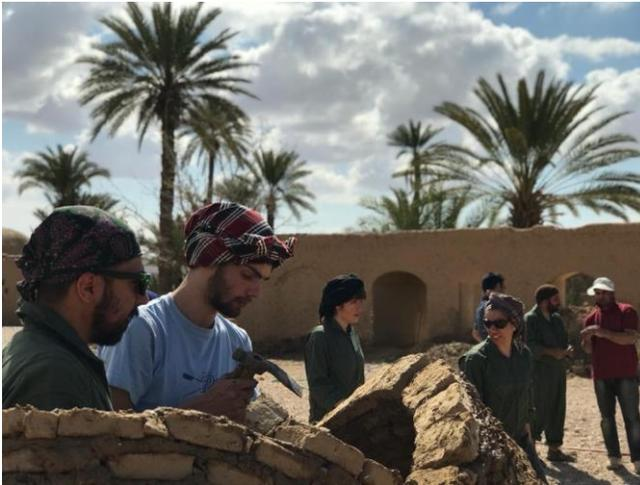
Fig. 55 : construction de voûte en adobe. (©E. REZAKHANI, 2018)
