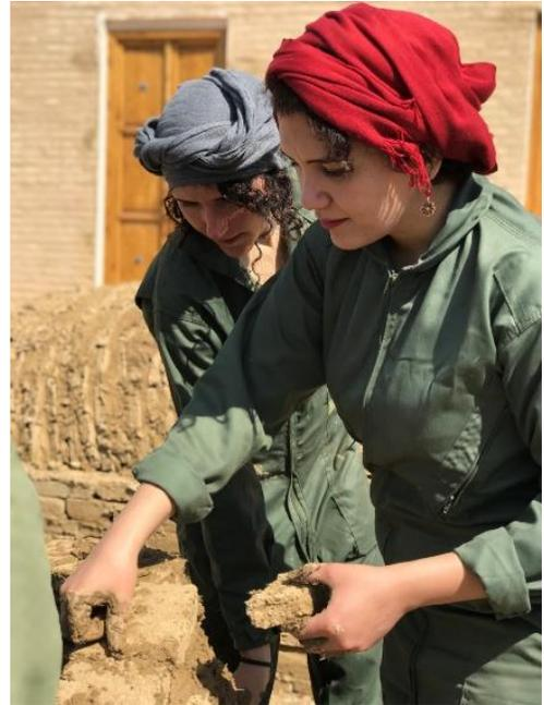
*Fig. 49 : construction de voûte en adobe. (©E. REZAKHANI, 2018)*
