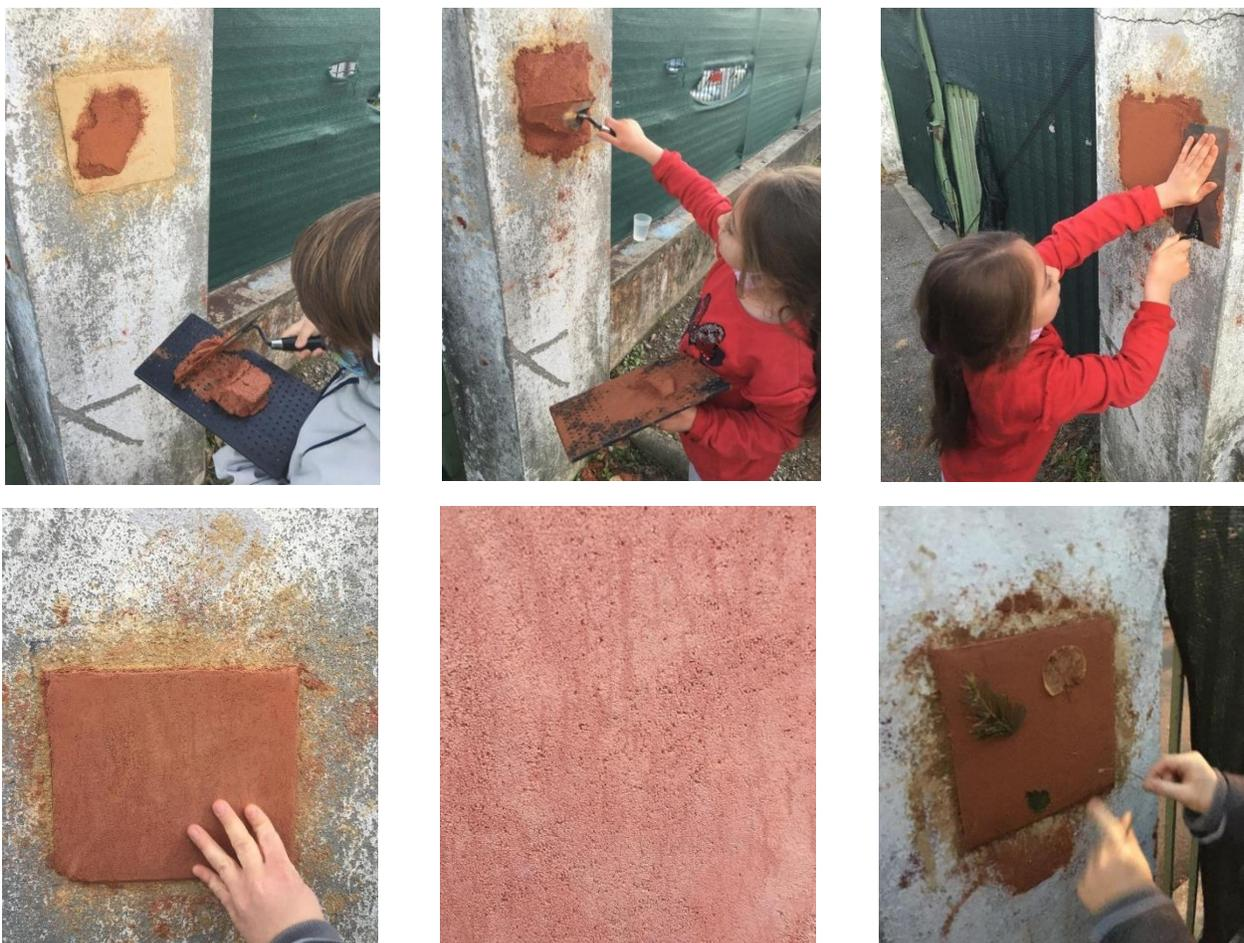
Fig. 92 : réalisation de la couche finition et de la décoration avec les feuilles, mélange utilisé : la terre rouge sable.
