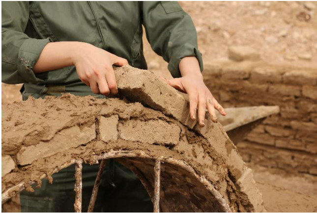
Fig. 53 : construction de voûte en adobe avec intelligence de la main. (©V. EBRAHIMZADEH,2018)
