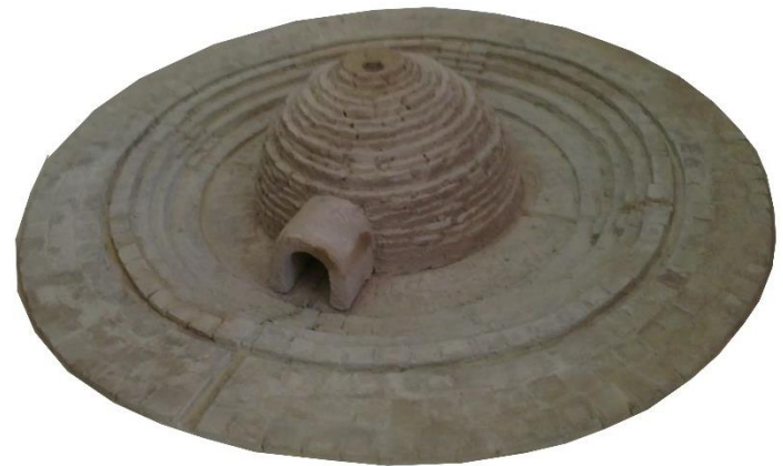
Fig. 80 : dans ce projet dôme se constitue d'un noyau central entouré par une espace vide. (©M. MAHDIEH,2013)
