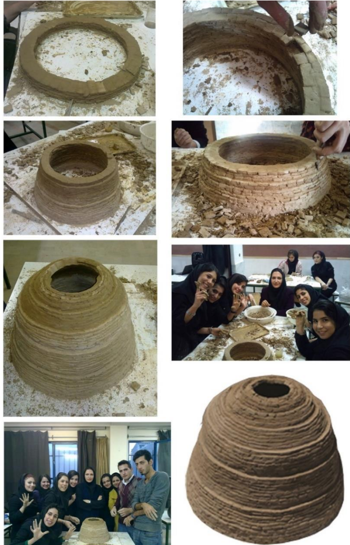
Fig. 84 : fabrication de la petite maquette d'un dôme de glacière à l'échelle 1/20. (©M. MAHDIEH,2012)
