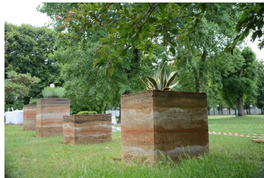
Fig. 142 : construction en pisé. (© M. MAHDIEH & ©S. BEYGI, 2017)
