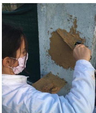
Fig. 90 : réalisation d'un enduit terre sur les poteaux de l'école Paul Langevin. (©M. MAHDIEH, 2020)
