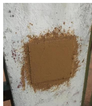
Fig. 90 : réalisation d'un enduit terre sur les poteaux de l'école Paul Langevin. (©M. MAHDIEH, 2020)
