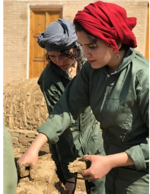
Fig. 49 : construction de voûte en adobe. (©E. REZAKHANI, 2018)
