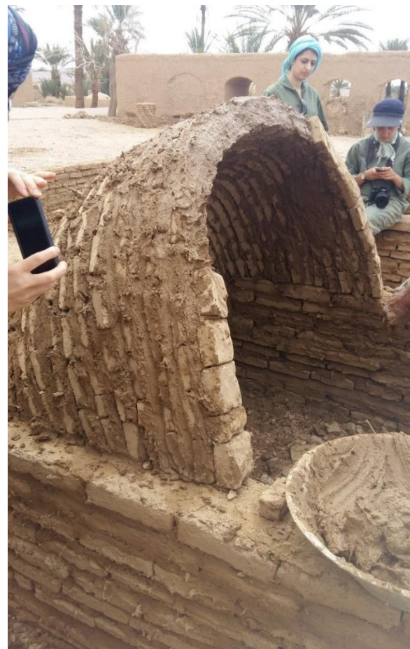
Fig. 59 : étapes de construction de l'une des voûtes. (©M. MAHDIEH, 2018)
