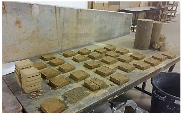
Fig. 129 : fabriquer les adobes. (©M. MAHDIEH, 2019)
