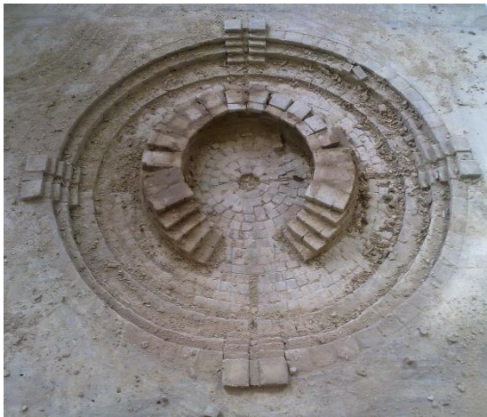
Fig. 80 : dans ce projet dôme se constitue d'un noyau central entouré par une espace vide. (©M. MAHDIEH,2013)
