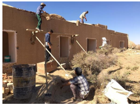
Fig. 74 : Ancien l'école, pendant la réparation. (©P. KHAZAELI, 2017)
