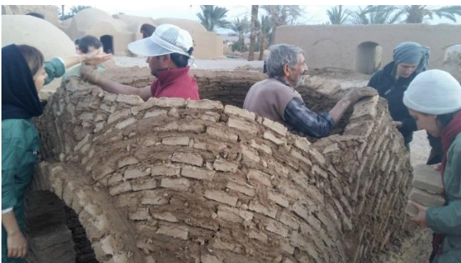
Fig. 57: construction de la coupole en adobe. (©M. MAHDIEH,2018)
