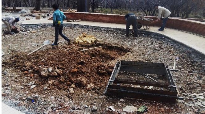
Fig. 43 : préparation du chantier pisé. (©M. MAHDIEH, 2018)
