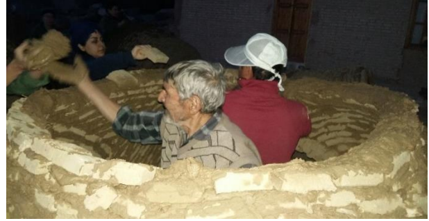
Fig. 64 : finition de la coupole. (©M. MAHDIEH, 2018)
