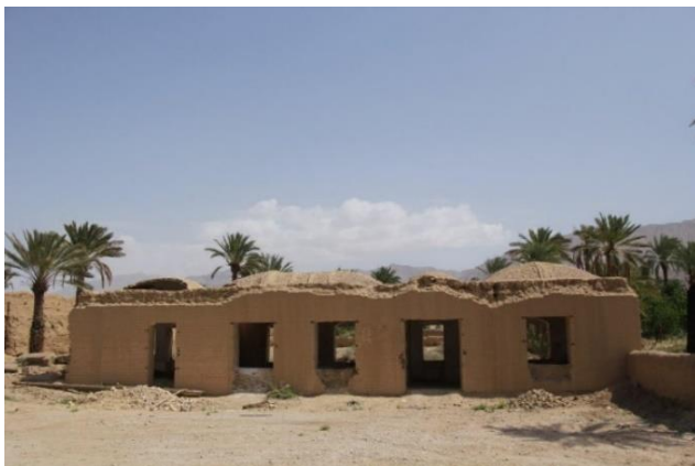
Fig. 73 : Ancienne école, avant réparation. (©A. PIRBADIAN, 2016)
