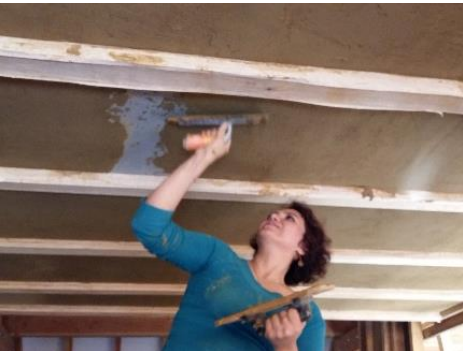
Fig. 141 : construction des panneaux terre. (© photo, archive M. MAHDIEH, 2017)
