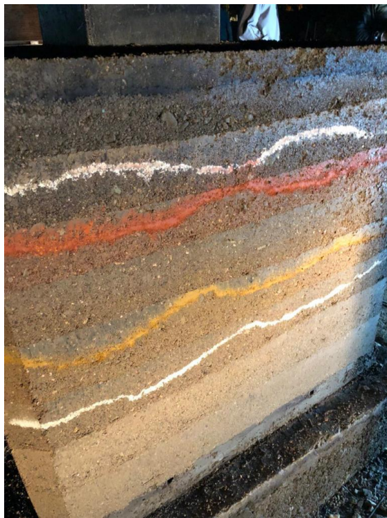
Fig. 45 : réalisation d'un monument décoratif en pisé. (©M. MAHDIEH, 2018)
