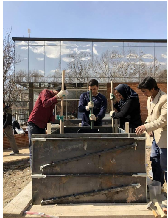
Fig. 44 : réalisation d'un pisé. (©S. BAYAT, 2018)
