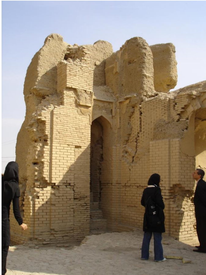
Fig.15 : observation et découverte d'un bâtiment en terre , Visite d'un groupe d'étudiants en architecture de l'université d'Art d'Ispahan, Isfahan, Iran. (©T. FARSI, le 2 novembre 2004)
