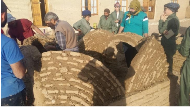
Fig. 63 : construction la coupole en adobe. (©M. MAHDIEH, 2018)
