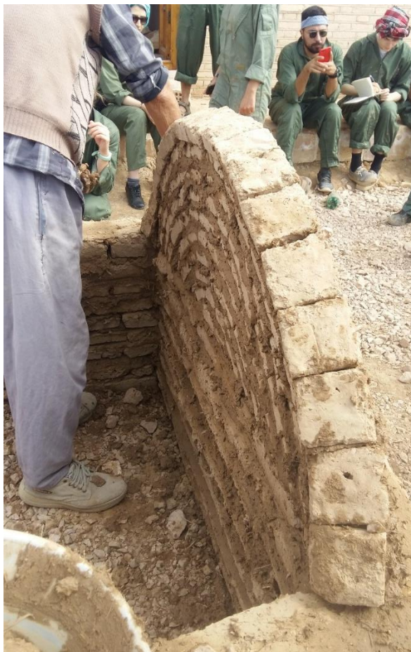
Fig. 59 : étapes de construction de l'une des voûtes. (©M. MAHDIEH, 2018)
