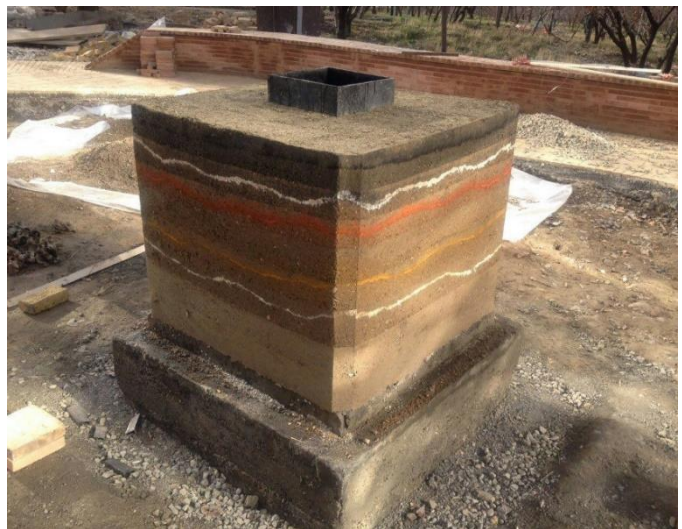
Fig. 44 : réalisation d'un pisé. (©S. BAYAT, 2018)
