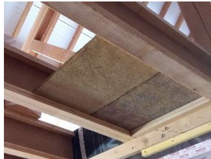
Fig. 141 : construction des panneaux terre. (© photo, archive M. MAHDIEH, 2017)
