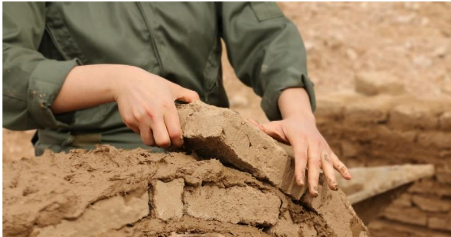
Fig. 4 : intelligence de la main , les mains qui construisent, Atelier international Improvising With Earth, Esfahk, Iran. (©V. EBRAHIMZADEH, Février 2018)
