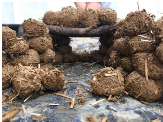
Fig. 103 : Construction en technique bauge. (© M. MAHDIEH, 2019)
