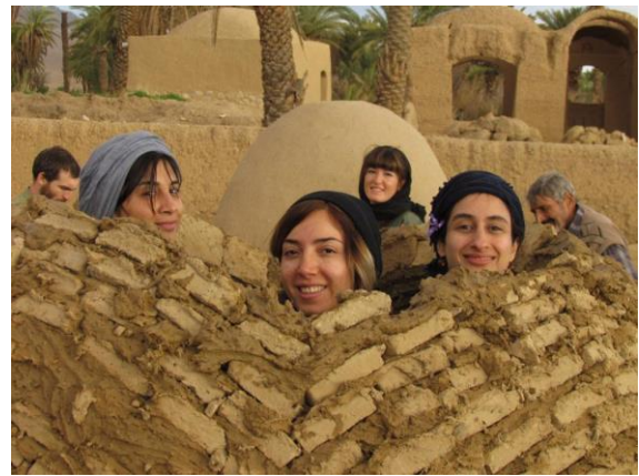
Fig. 56 : construction de la coupole en adobe. (©M. NIKOOYI, 2018)
