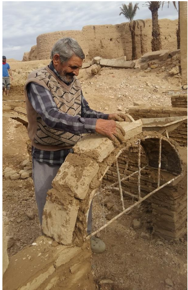
Fig. 52 : étapes pour construire des voûtes en adobe. (©M. MAHDIEH,2018)
