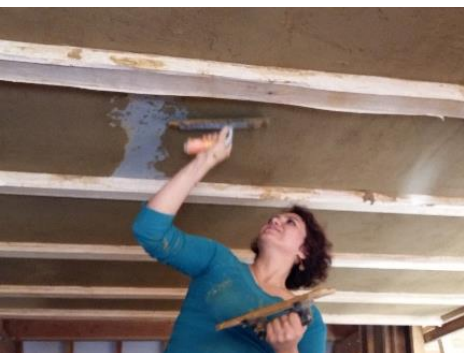
Fig. 141 : construction des panneaux terre. (© photo, archive M. MAHDIEH, 2017)
