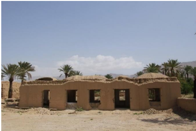
Fig. 73 : Ancienne école, avant réparation. (©A. PIRBADIAN, 2016)
