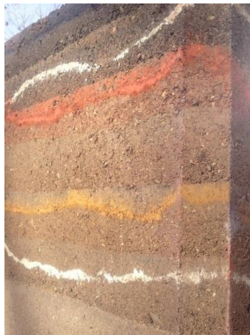
Fig. 33 : construction en pisé. (©M. MAHDIEH, 2018)
