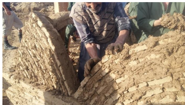
Fig. 52 : étapes pour construire des voûtes en adobe. (©M. MAHDIEH,2018)
