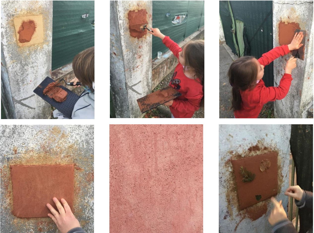
Fig. 92 : réalisation de la couche finition et de la décoration avec les feuilles, mélange utilisé : la terre rouge sable. (©M. MAHDIEH, 2020)
