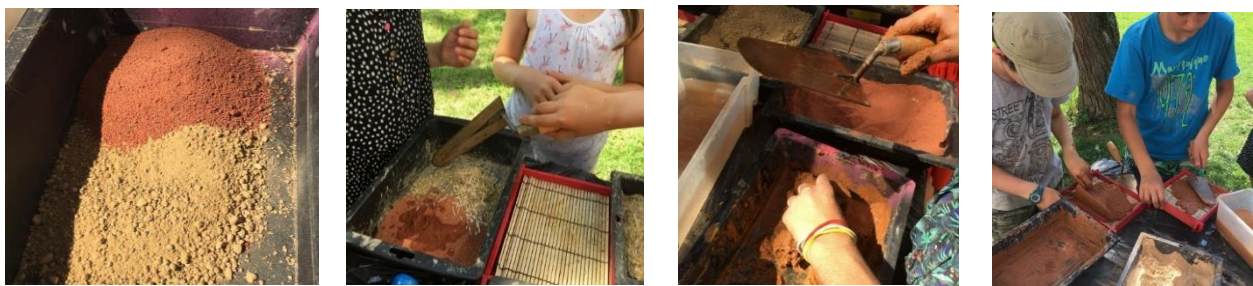
Fig. 87 : réalisation d'un enduit terre sur la petite canisse. (©M. MAHDIEH, 2019)
