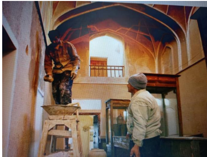
Fig. 19 54 : restauration de la maison historique de PIRNIA, transmission des savoir-faire Maître-Elève d'une génération à l'autre
