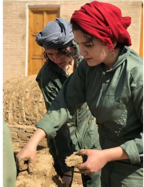
Fig. 49 : construction de voûte en adobe. (©E. REZAKHANI, 2018)
