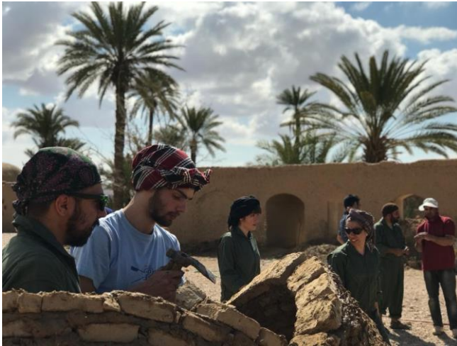
Fig. 55 : construction de voûte en adobe. (©E. REZAKHANI, 2018)
