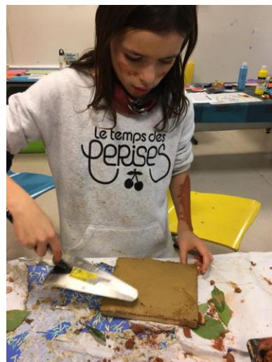
Fig. 89 : réalisation d'un enduit terre sur un petit morceau plat en bois. (©M. MAHDIEH, 2019)
