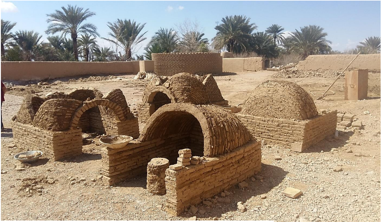
Fig. 68 : construction de quatre prototypes en adobe. (©M. MAHDIEH, 2018)
