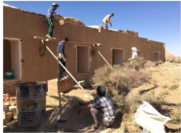
Fig. 74 : Ancien l'école, pendant la réparation. (©P. KHAZAELI, 2017)
