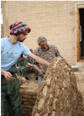
Fig.20 : Oos Ali, en train de réparer une voûte en travaillant avec la terre, atelier international Improving With Earth, Esfahk, Iran. (©Vahideh EBRAHIMZADEH, février 2018)
