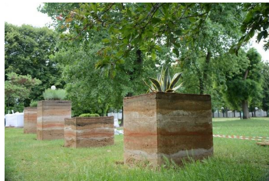
Fig. 142 : construction en pisé. (© M. MAHDIEH & ©S. BEYGI, 2017)
