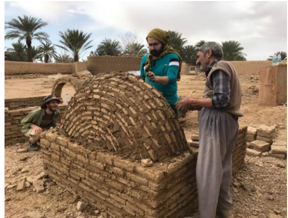
Fig. 54 : construction de voûte en adobe. (©T. BEHBOODI,2018)
