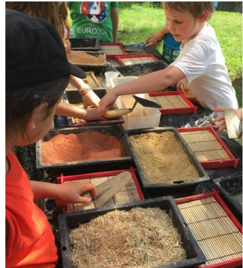
Fig. 86 : préparation les matériaux pour enduit terre. (©M. MAHDIEH, 2019)
