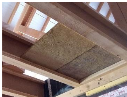
Fig. 141 : construction des panneaux terre. (© photo, archive M. MAHDIEH, 2017)
