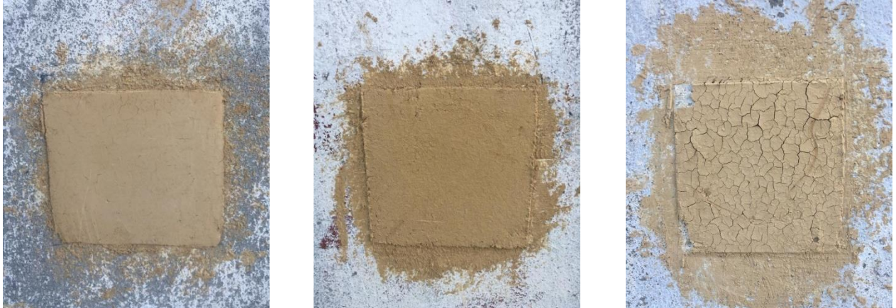
Fig. 91 : expérimentation des trois types de mélange pour réaliser la première couche d'enduit terre sur les poteaux : À partir de la gauche Image 1 : la terre Commelle+ sable fin/ image 2 : la terre Commelle+sable fin + paille hachée/ image 3 : la terre Commelle + sable 2 mm Le résultat : image 1 : ça tient bien sur le poteau, et apparait un peu fissuré/ image 2 : un peu fissuré mais ça tient bien sur le poteau/ image 3 : ça ne tient pas sur le poteau et il y a beaucoup de fissures, donc celle-ci ne convient pas pour réaliser l'enduit de finition par-dessus .(©M. MAHDIEH, 2020)
