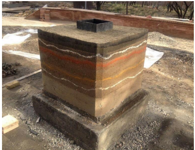
Fig. 44 : réalisation d'un pisé. (©S. BAYAT, 2018)
