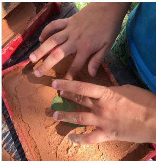
Fig. 88 : utilisation des feuilles pour donner la texture finale sur la couche finition. (©M. MAHDIEH, 2019)
