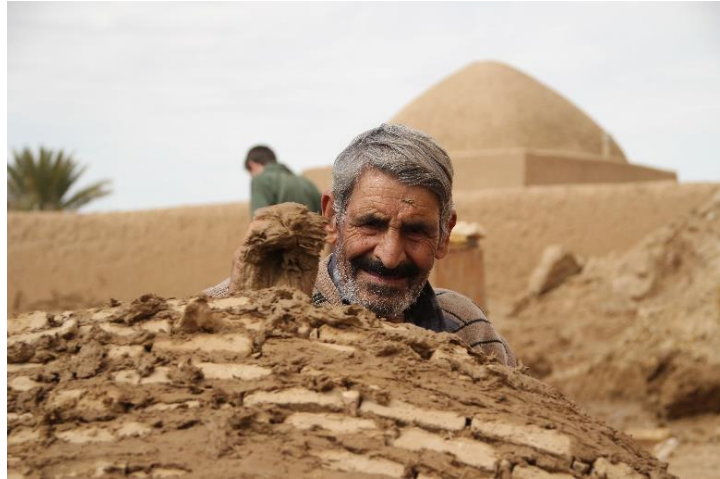
Fig.20 : Oos Ali, en train de réparer une voûte en travaillant avec la terre, atelier international Improving With Earth, Esfahk, Iran. (©Vahideh EBRAHIMZADEH, février 2018)
