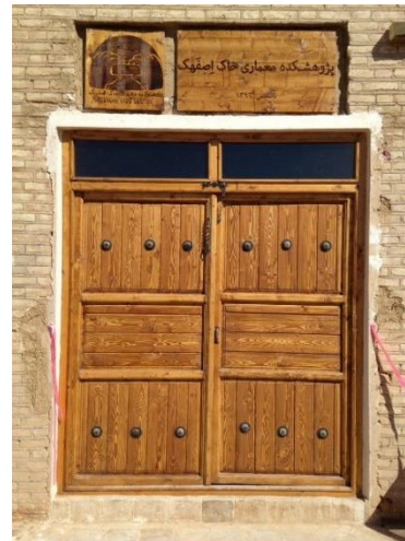
Fig. 76 : un équipement de l'école, la porte d'entrée. (©H. BAGHERI, 2017)
