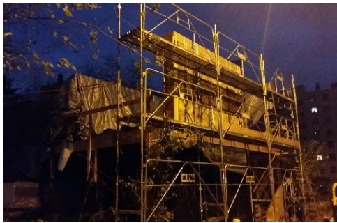
Fig. 140 : construction en paille. (© M. MAHDIEH, 2017)
