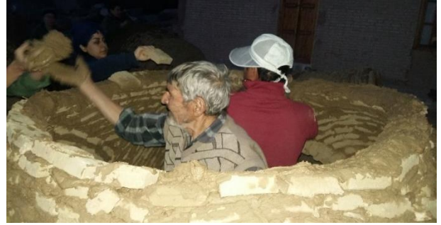
Fig. 64 : finition de la coupole. (©M. MAHDIEH, 2018)
