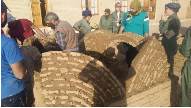
Fig. 63 : construction la coupole en adobe. (©M. MAHDIEH, 2018)
