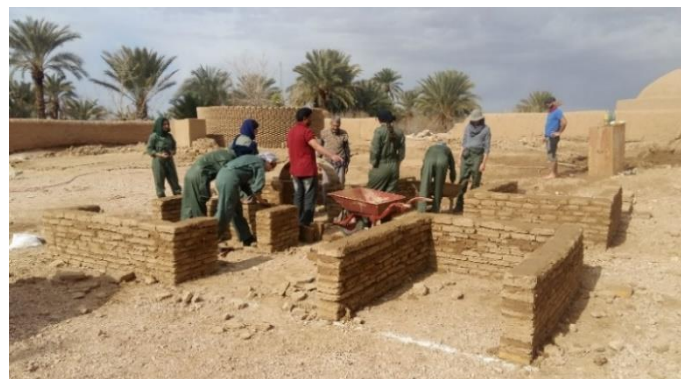
Fig. 50 : fabriquer les adobes et préparation des murs pour construction des voûtes en adobe. (©M. MAHDIEH,2018)
