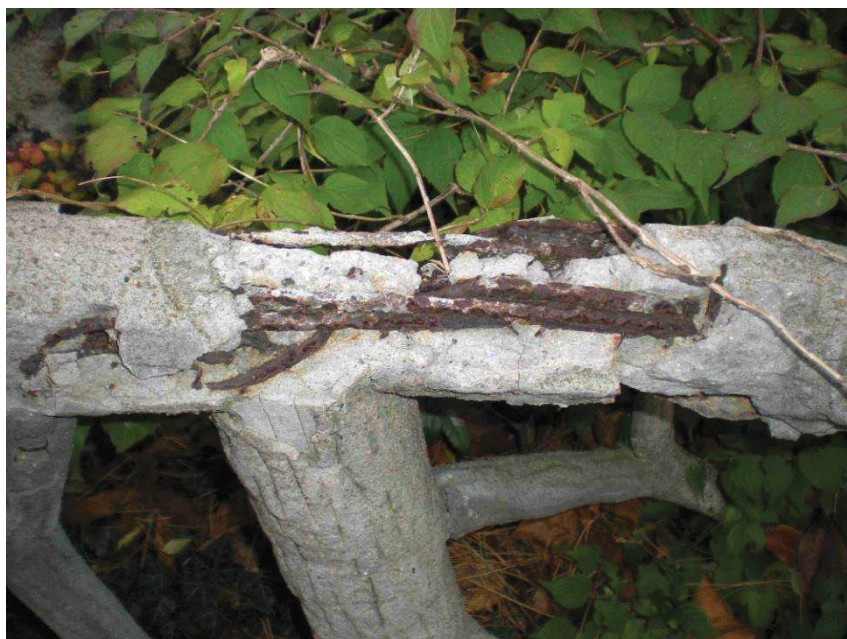
Illustration 11 , Rampe de l'escalier imitation bois, en ciment armé / vue de la structure intérieure, parc Montsouris
