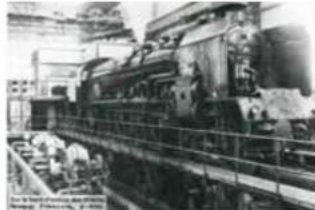
Banc d'essais des locomotives, 1933
