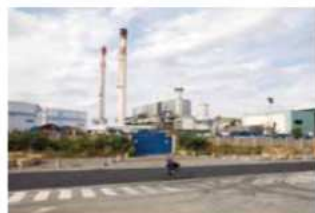
Les cheminées de la centrale thermique
