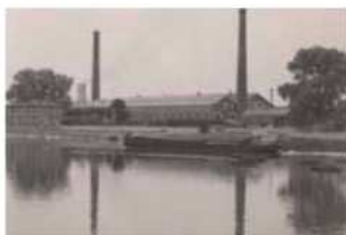
Centrale électrique, dite « usine de l'Air Liquide », 1899-1901
