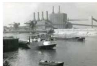
Centrale thermique au charbon Arrighi, 1925-1931
