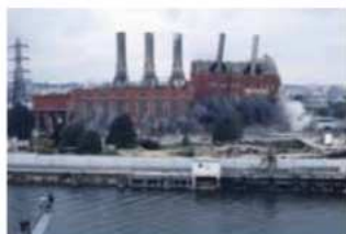
Démolition de la centrale Amighi, 1991-1992
