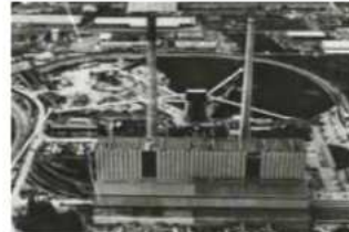
Centrale électrique à charbon, 1966
