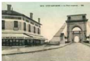
Pont du Port-à-Français, 1913-1928
