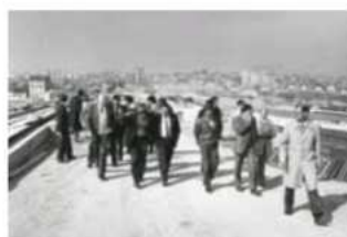
Chantier de l'autoroute A86, 1984
