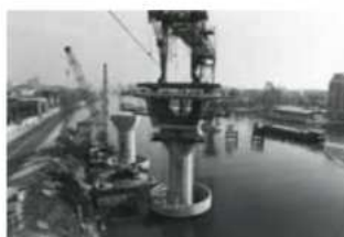
Chantier de l'autoroute A86, 1984
