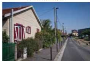
Maison de cheminot
