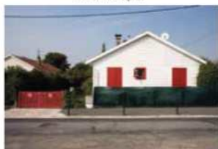
Maison de cheminot
