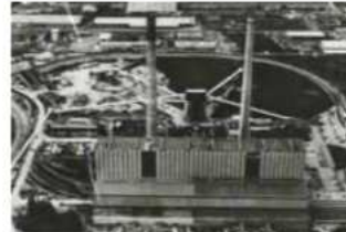
Centrale électrique à charbon, 1966
