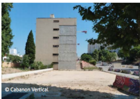
Figure 23 : Après démolitions, Vallon de Malpassé, Cabanon Vertical, 2013
