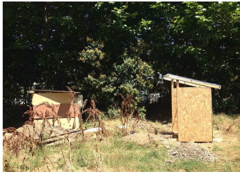
Chantier de toilettes sèches (Crédit : ASF)
