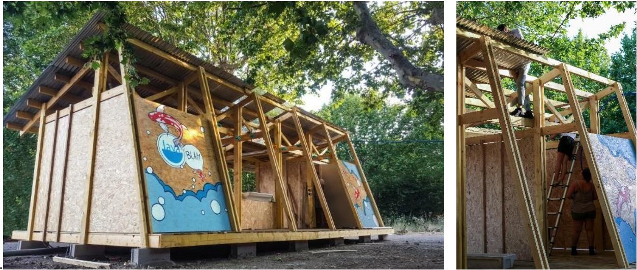
Réalisation des douches et lavoirs (Crédit : Studio Cyrille Hanappe)
