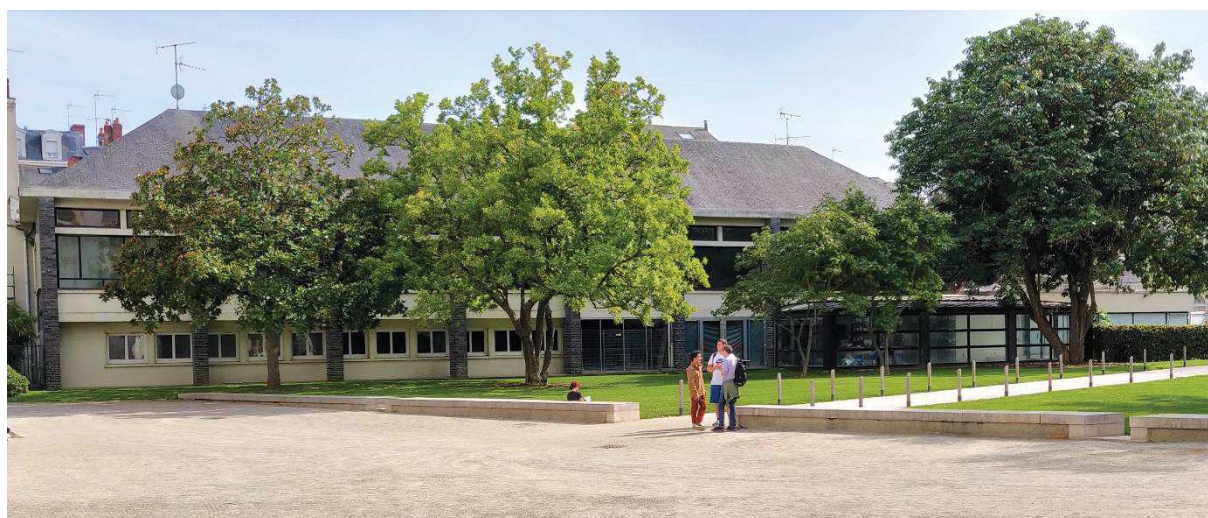
L'ancien restaurant universitaire de l'École des beaux-arts en travaux. Cliché réalisé en septembre 2019.
