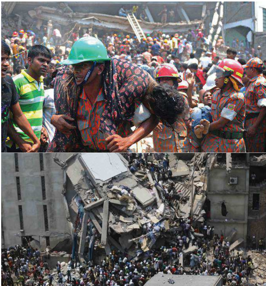
L'effondrement du Rana Plaza, photo haut – Reuters, Andrew Biraj , l'Express 21/12/2015
