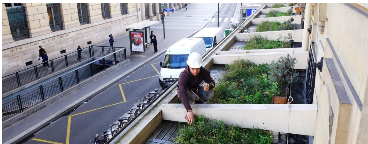
Figure 33 : Petits espaces de toitures
