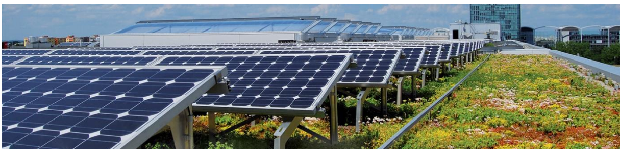
Figure 44 : Couple de panneaux solaires et de toiture végétale
