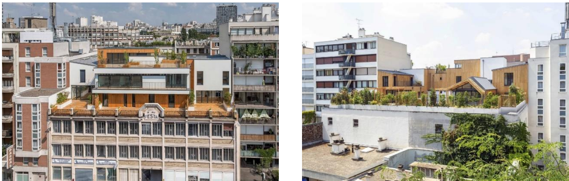
Figure 28 : Opération d'aménagement d'un rooftop en 3 maisons en bois à Paris
