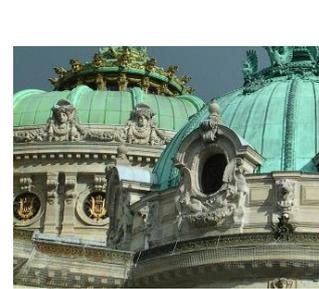
**Figure 8 : Toit en cuivre**
