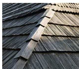
Figure 6 : Toit en bois
