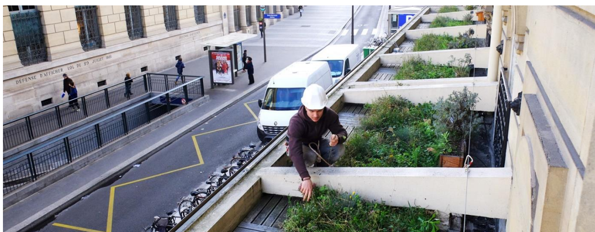
Figure 33 : Petits espaces de toitures
