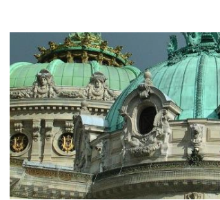
Figure 8 : Toit en cuivre
