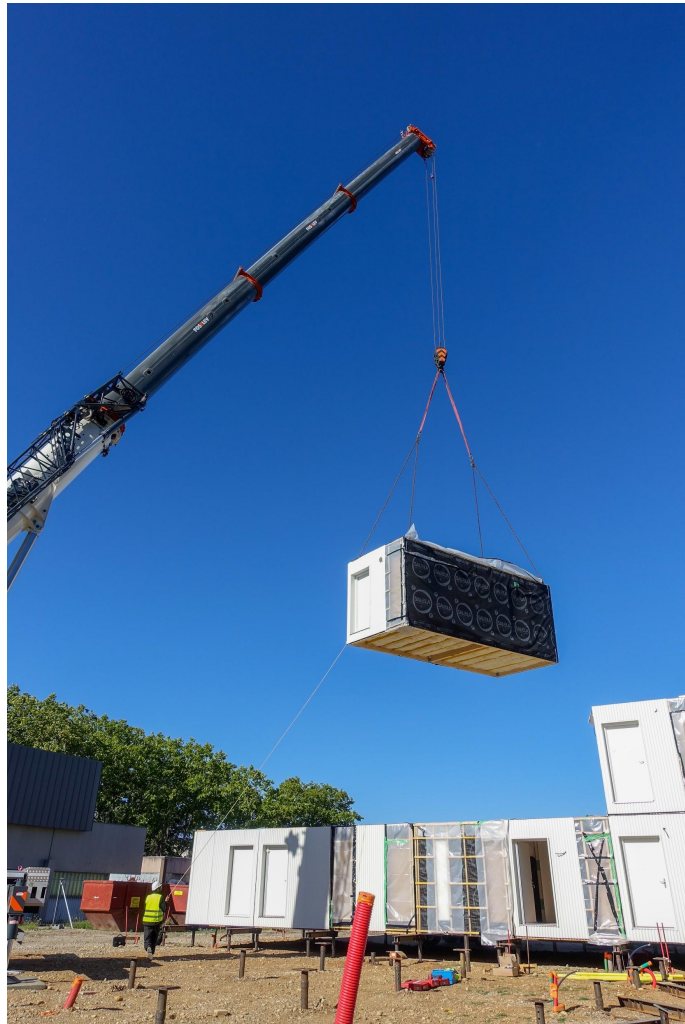
Illustration 32 : Installation des modules d'habitats financés par l'IUA sur le site de l'Autre Soie, juillet 2020. Source : Mission Carré de Soie
