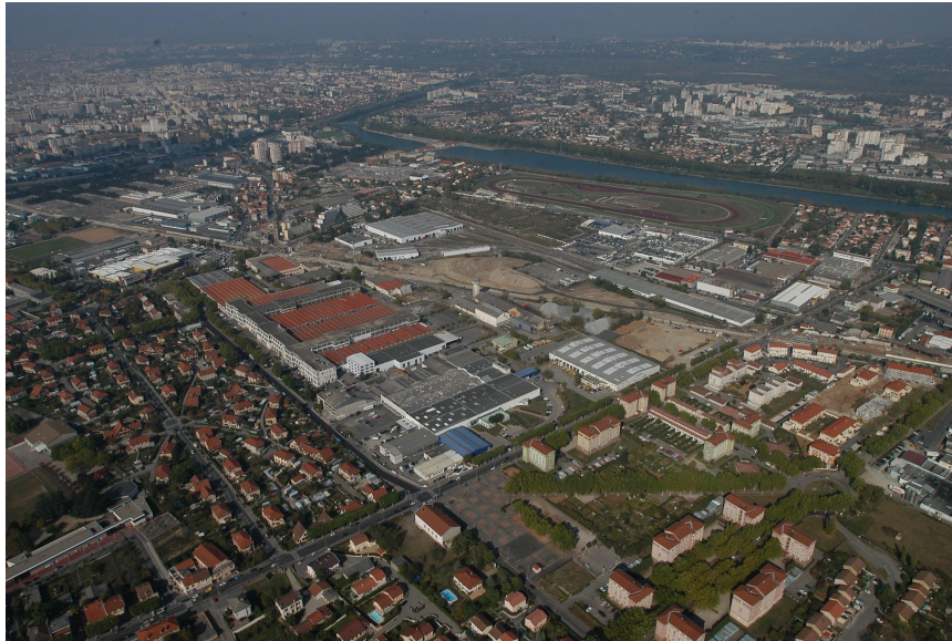
Illustration 3 : Vue aérienne du Nord du site du Carré de Soie en 2005 Source : Mission Carré de Soie
