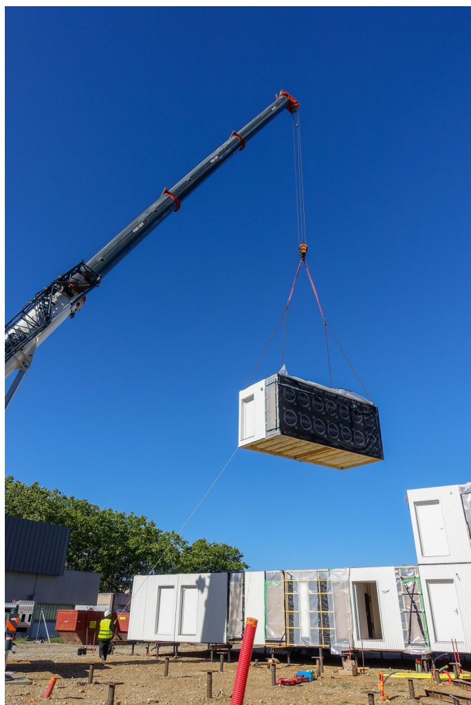
Illustration 32 : Installation des modules d'habitats financés par l'IUA sur le site de l'Autre Soie, juillet 2020.
