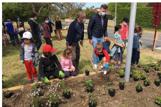
Figure 17 : Chantier végétalisation le 9 mai 2021
