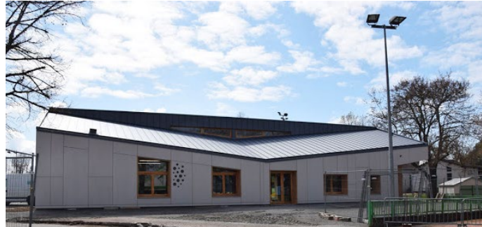
Figure 18 : La nouvelle cantine en bois et paille Source : David Fayolle (Wild Architecture)
