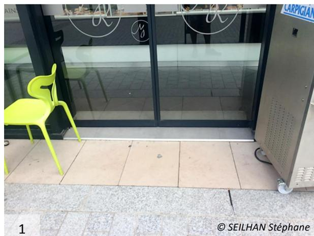
**Figure 42 : une différence de niveaux handicapante**
