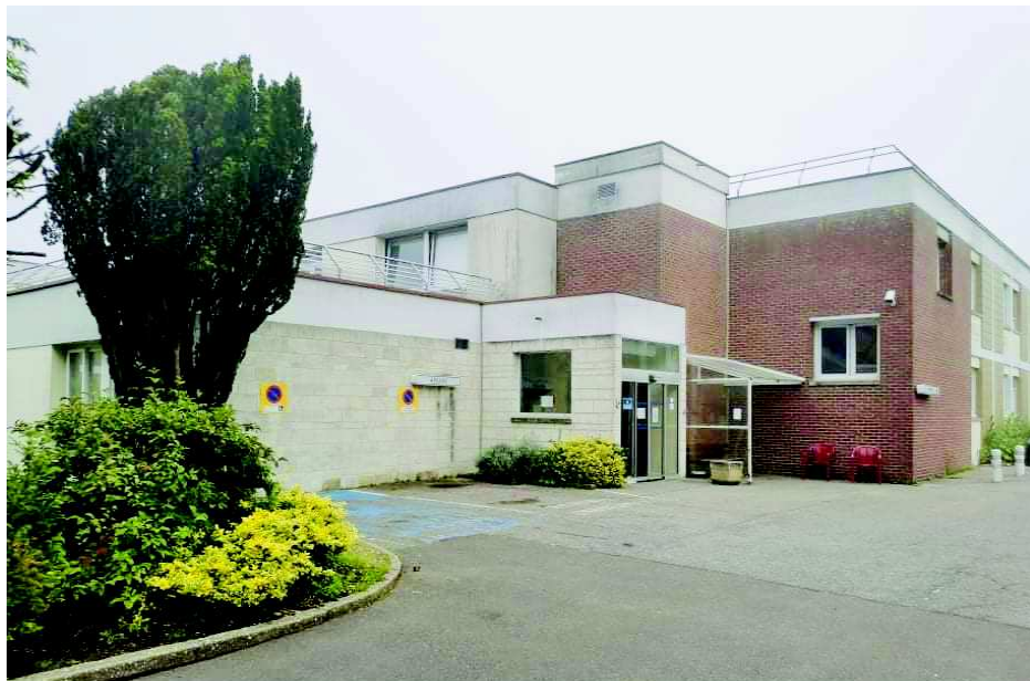
Figure 2 - Bâtiment Arcadie (USLD) du site de Boucicaut (Travail de l'auteur)
