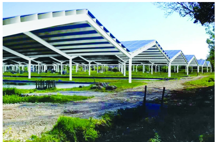
Illustration 22: Structure d'agrivoltaïsme au dessus de plusieurs bassins d'élevage d'esturgeons à Neuvic, en Dordogne (Source : Lusine nouvelle, « Un triple effet solaire sur le caviar de Neuvic, 22 février 2018, https://www.usinenouvelle.com/article/un-triple-effet-solaire-sur-le-caviar-neuvic.N655724 )
