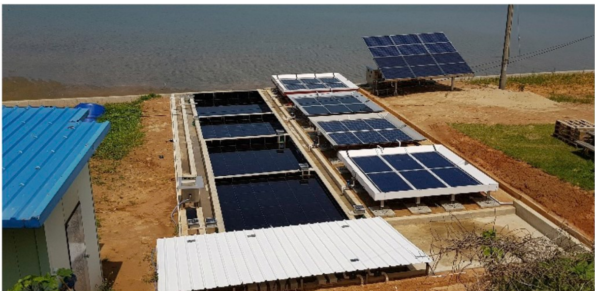
Illustration 6: Le dispositif expérimental permettant de comparer les panneaux solaires submergés dans les bassins salicoles avec des installations photovoltaïque au sol. (Source : BONGSUCK K. et al, 2020)
