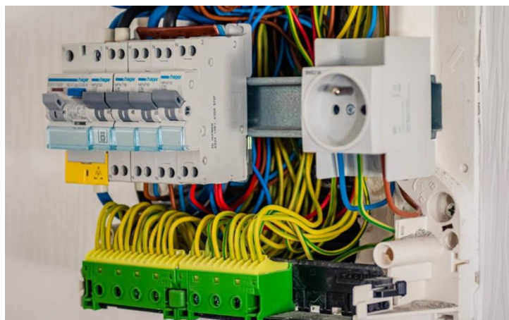
Figure n° 22 : Installation électrique « classique » d'un particulier respectant les standards colorés en vigueur en France.
