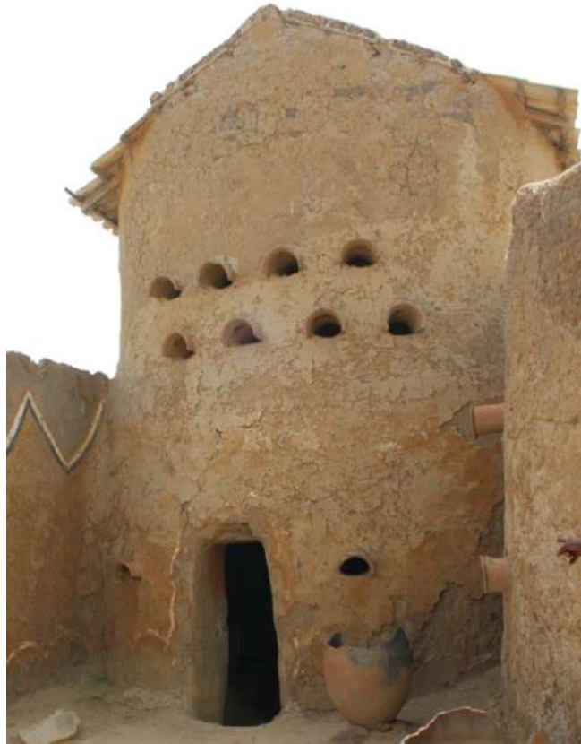
Figure 39 : photographie de la tour gauche, avec une toiture à deux pentes , photographie personnelle, juin 2019
