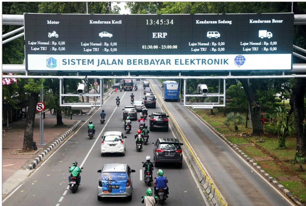
Figure 42 : Photo d'un portique du système de péage urbain électronique, en vue d'une future mise en œuvre
