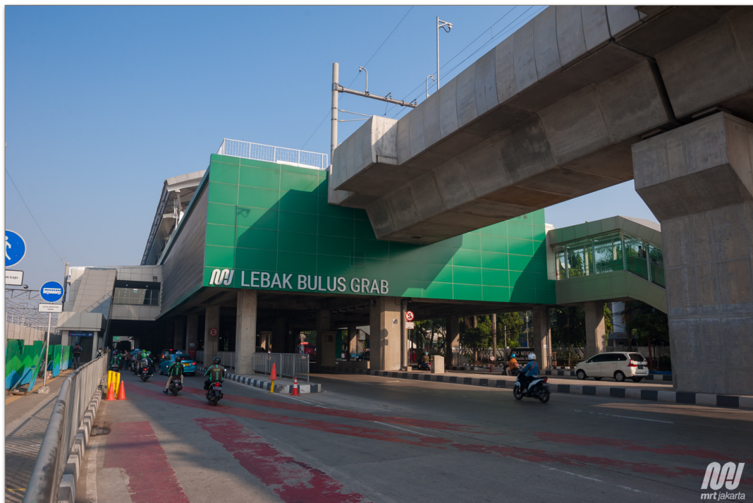
Figure 39 : Photo de la station de MRT de « Lebak Bulus Grab »
