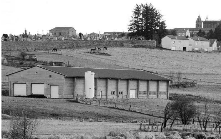
Figure 3-1 : Intégration architecturale et paysagère de la station d'épuration de Saugues
