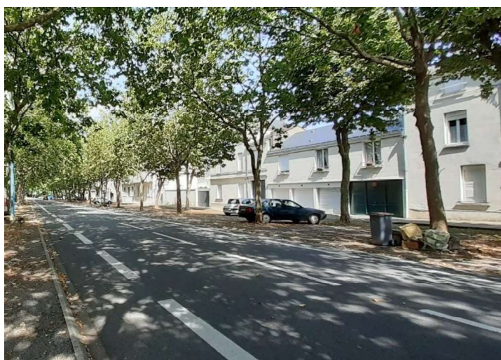
Figure 29 : Avenue Commentry en juin 2021 (Ballan, 2021).
