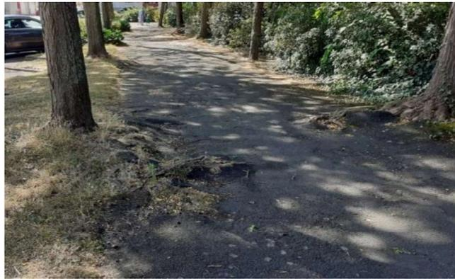
Figure 4 : Dégradation des chaussées par les racines de *Robinia pseudoacacia* autour de la place Verdun à Saumur (Ballan, 2021).
