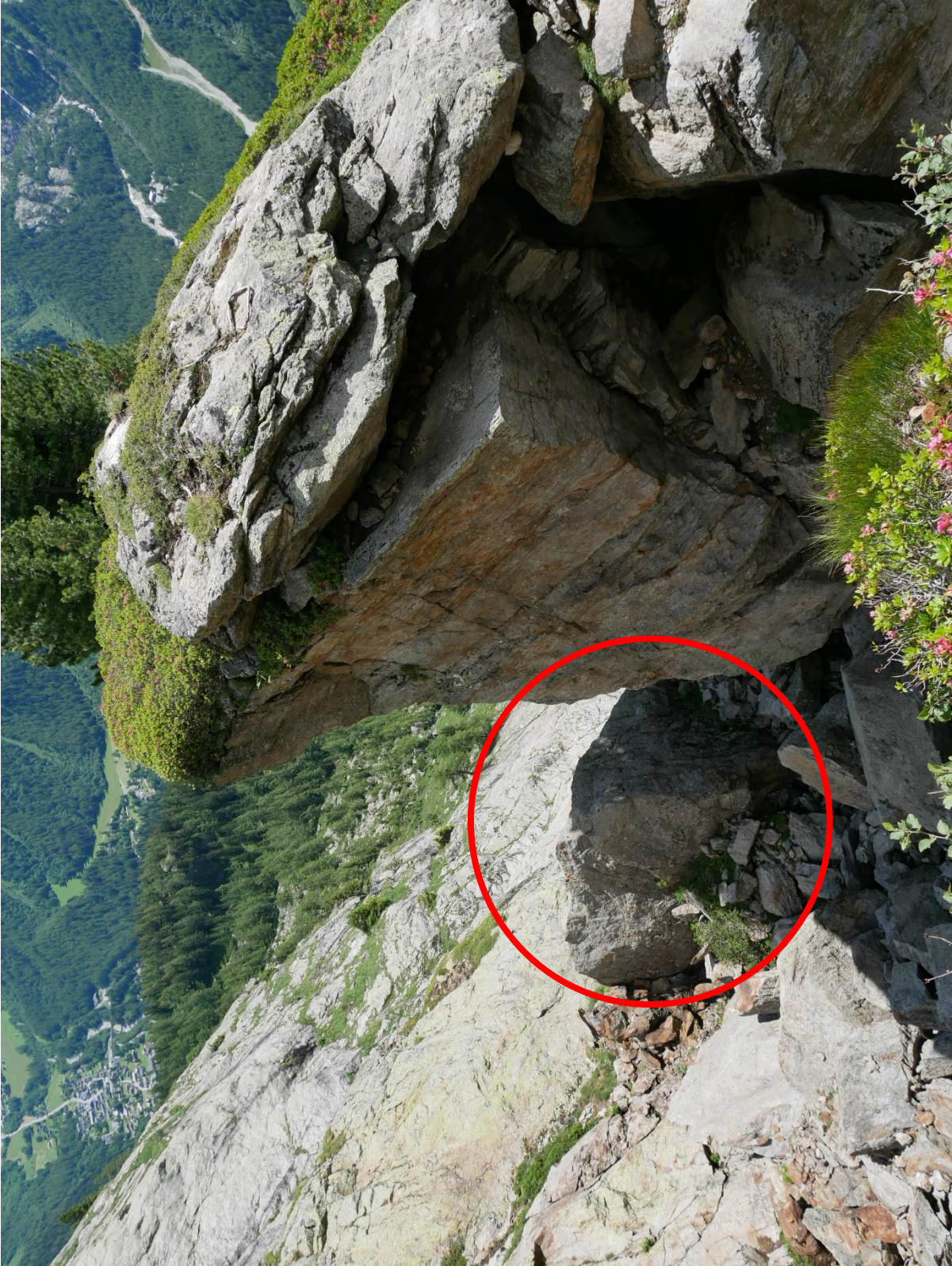
ANNEXE 3 – Bloc éboulé en-dessous de la crevasse NE.
