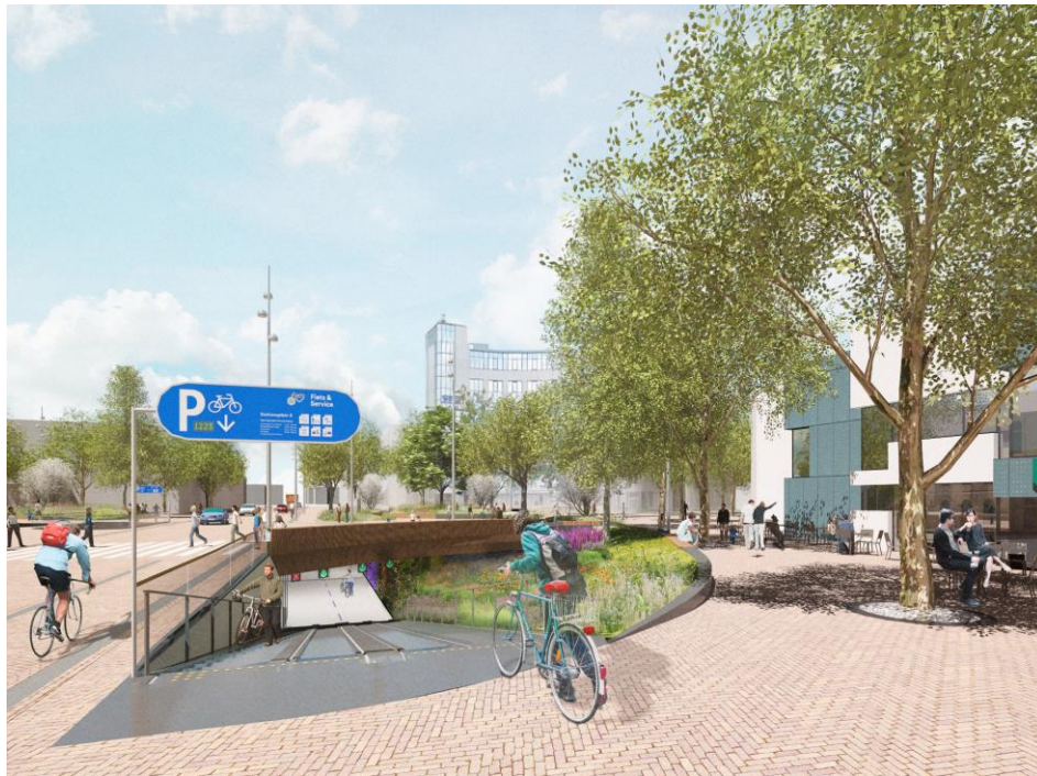
Figure 24 : Nouveau Parking vélo souterrain de la gare de Zwolle ouvert en 2020, Image de synthèse, Source : https://www.kraaijvanger.nl/en/projects/bicycle-parking-and-square-zwolle/ , consulté le 16/08/2021
