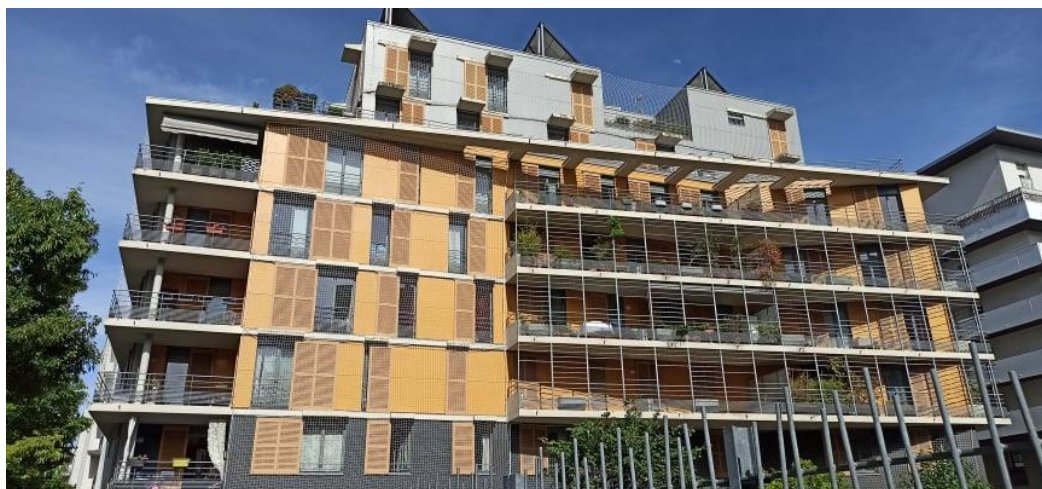
Figure 26 : Immeuble de logements de la ZAC , un bâti écologique et innovant , Joel Behavana
