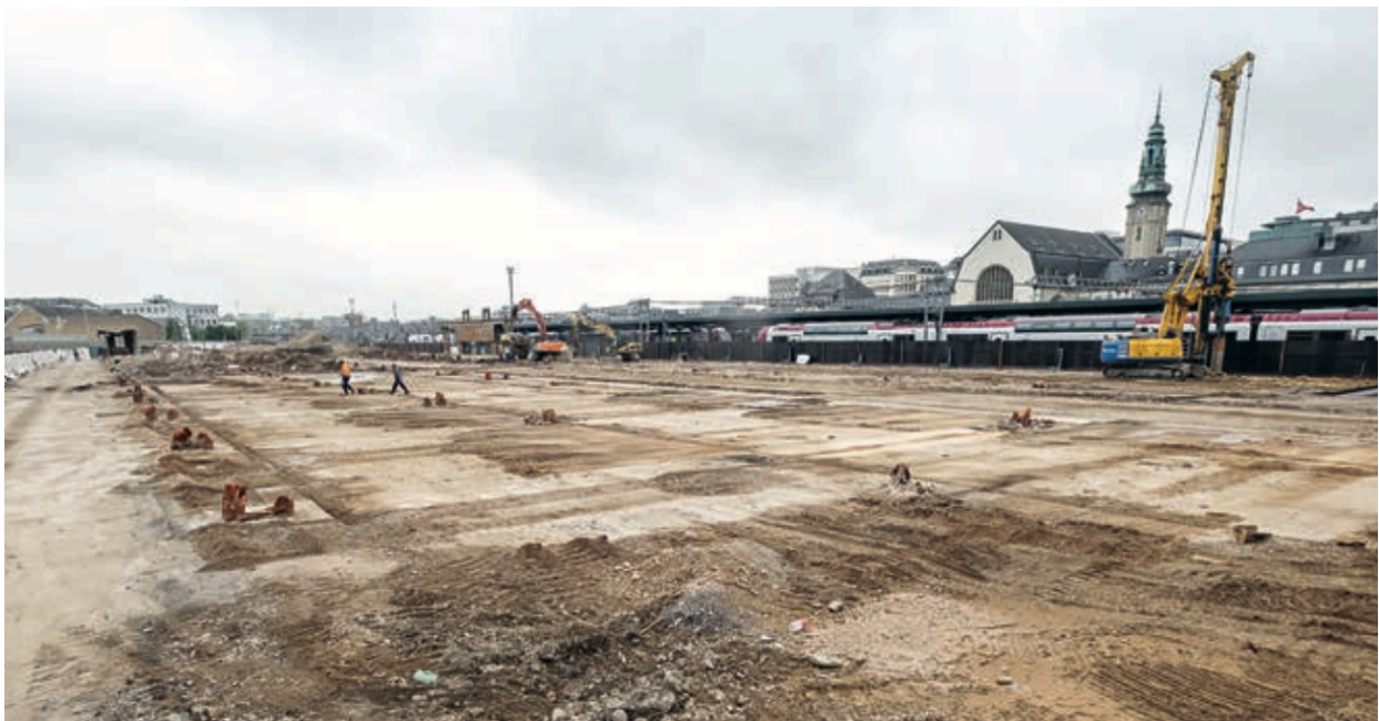
Extension de la gare centrale (CFL)
