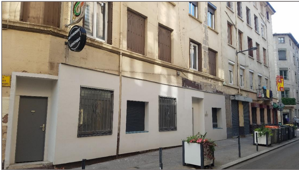
Figure 244 : Ancien local commercial transformé en logement, rue Roger Salengro.
