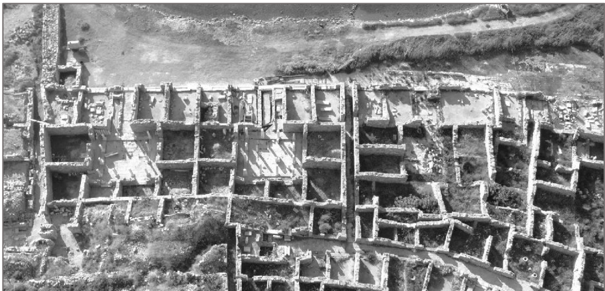
Figure 1 : Groupe de trois magasins, chacun est organisé autour d'une cour à péristyle. Sur la partie supérieure de cette photographie, face à la mer, une dizaine de « pièces polyvalentes » font office de cellules commerciales, elles sont regroupées sur la même façade - photographie prise par Christophe Gaston (Karvonis, 2008).
