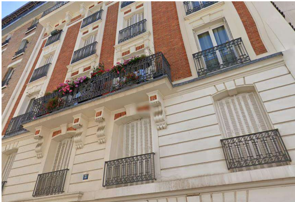
Photographie 2 : Terrasse de logements collectifs à Issy-les-Moulineaux.
