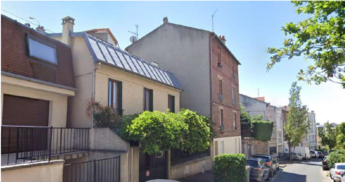
Photographie 3 : Façade d'une maison individuelle à Issy-les-Moulineaux Sud.
