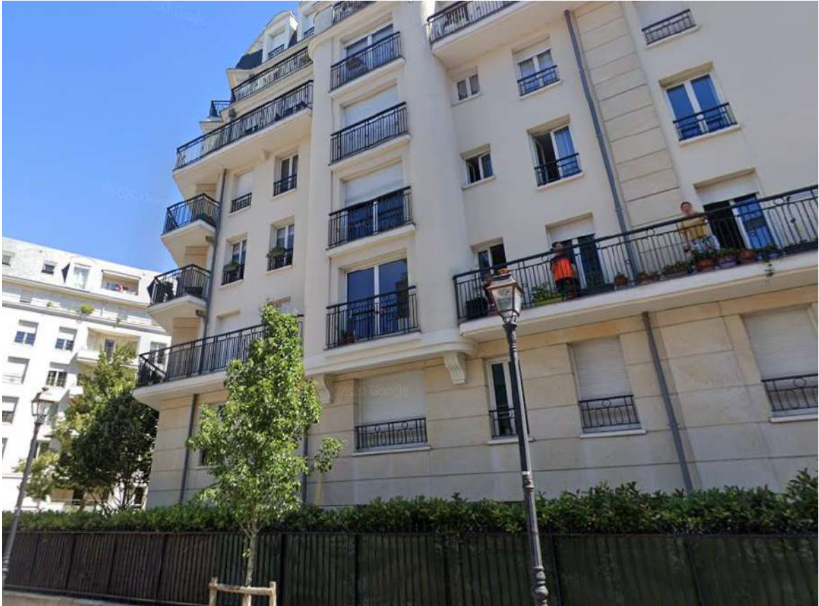
Photographie 1 : Terrasse de logements collectifs à Issy-les-Moulineaux.
