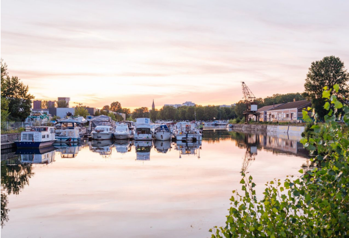
Figure 1 : Le bassin de la Citadelle et les anciennes halles portuaires (droite)
