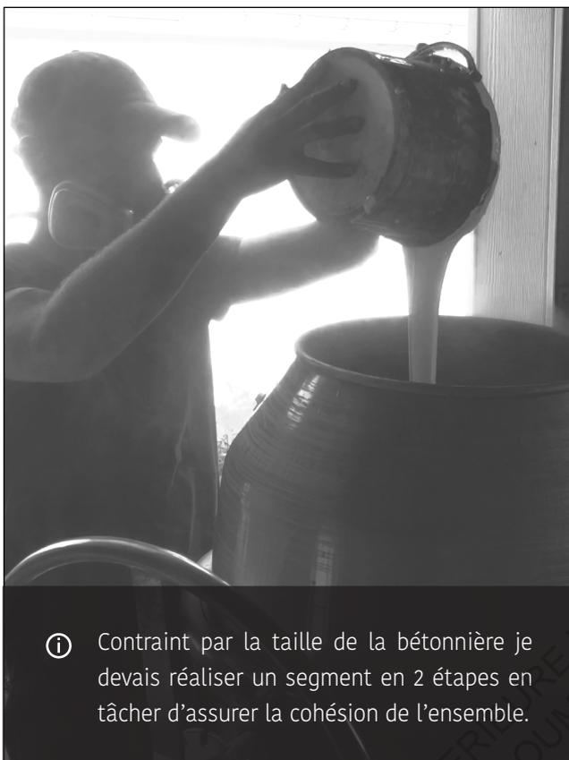
**7 Mélange :** le mélange se faisait avec une bétonnière de façon à couler de grandes quantités de matière en un minimum de temps, sachant que la colle avait une prise relativement rapide.
