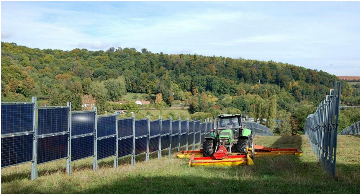
Figure 22: Centrale agrivoltaïque de modules horizontaux bifaciaux orientés est-ouest (Next2Sun GmbH, 2021)
