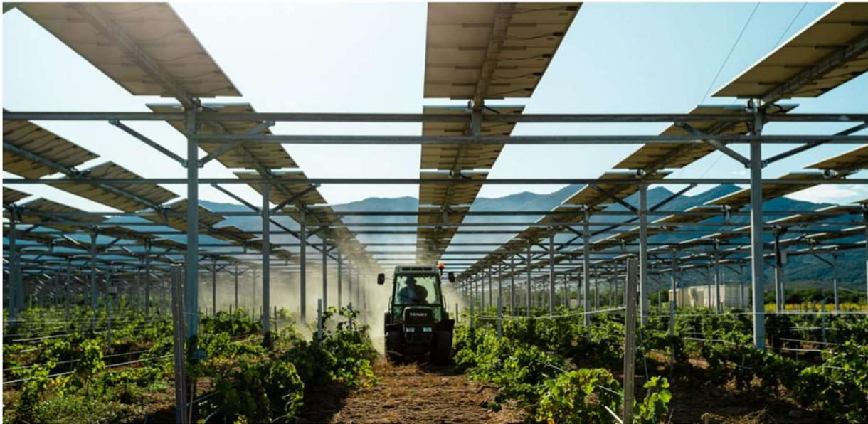
Figure 20: Installation de persiennes photovoltaïques mobiles au-dessus d'une exploitation maraichère (Sun'Agri, 2019)
