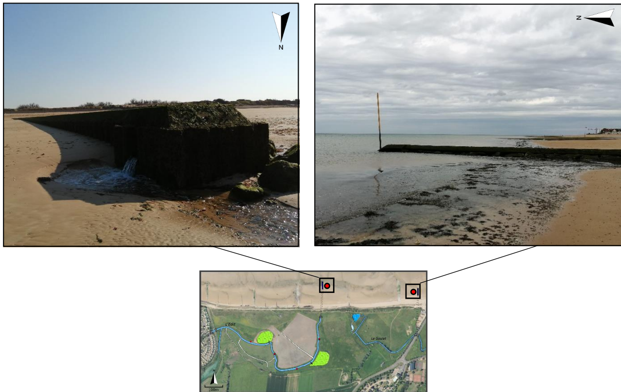
Figure 129 : Photographies des émissaires gravitaires, le flux des cours d'eau est directement évacué dans la mer (M. Marie, Mai 2021)
