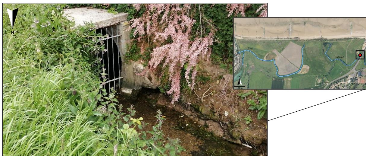
Figure 122 : Photographie du ruisseau du Goulet, buse transitoire entre le pré et le marais (M. Marie, Mai 2021)
