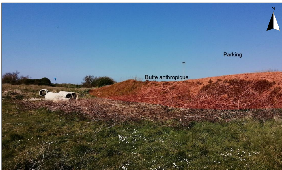
Figure 78 : Photographie du talus anthropique séparant le marais du parking en contrebas, frange est du marais (M. Marie, Mai 2021)
