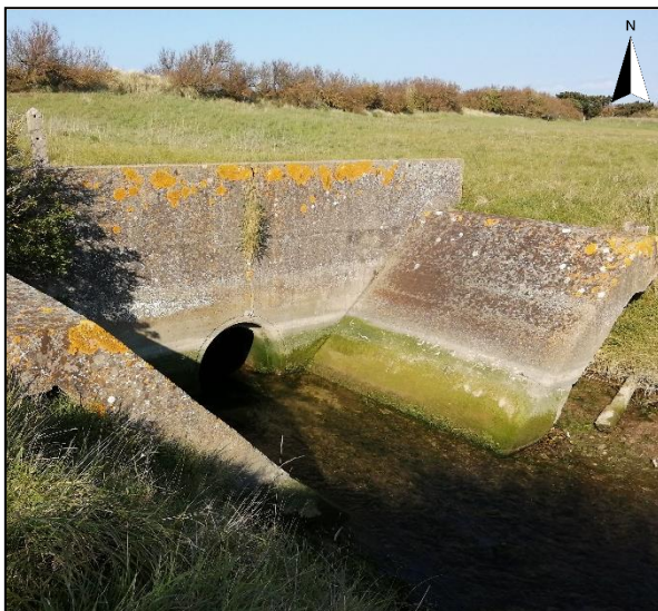
Le bras mort de la Seulles – Marée basse
