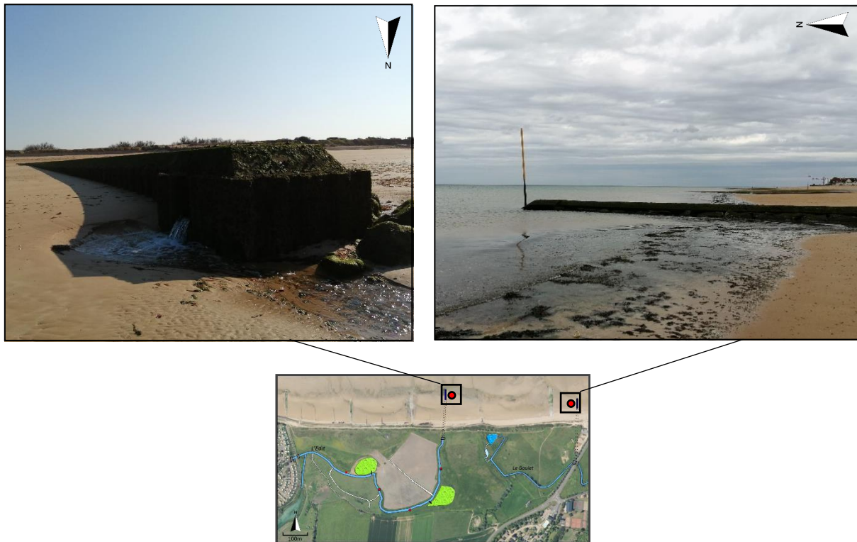
Figure 129 : Photographies des émissaires gravitaires, le flux des cours d'eau est directement évacué dans la mer (M. Marie, Mai 2021)
