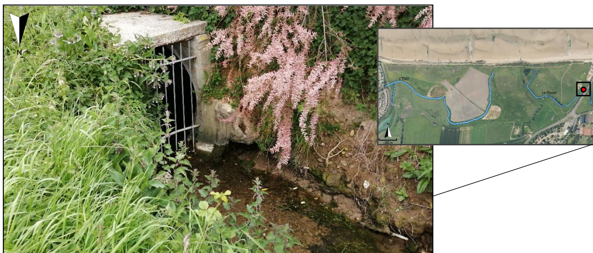
Figure 122 : Photographie du ruisseau du Goulet, buse transitoire entre le pré et le marais (M. Marie, Mai 2021)
