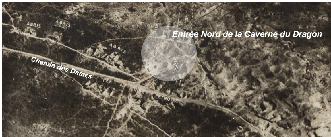
Figure 5 : Photographie aérienne de la ligne de Front au niveau de la Caverne du Dragon (Source : « Chemin des Dames 1917-2017 » Conseil Départemental de l'Aisne)
