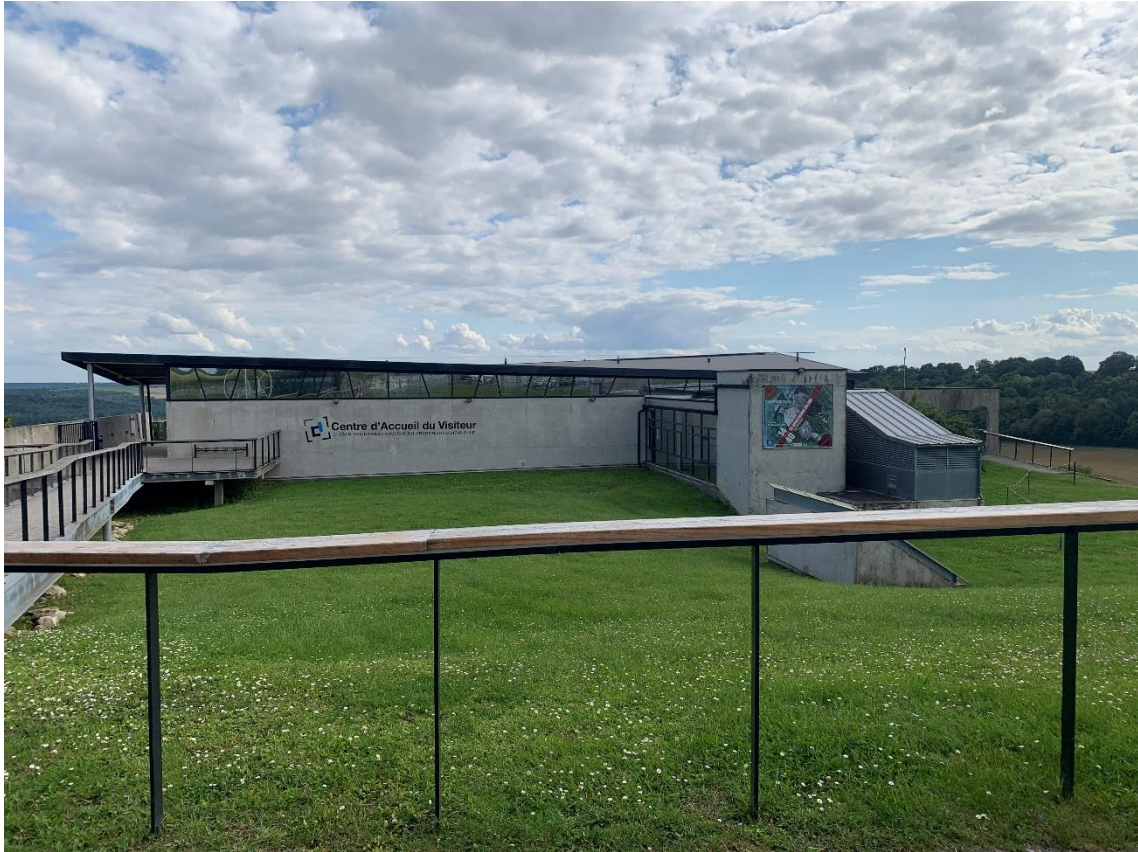
ANNEXE IV : La caverne du Dragon : une ancienne « creute » réhabilitée en musée départemental (Source : Nathan Gay)
